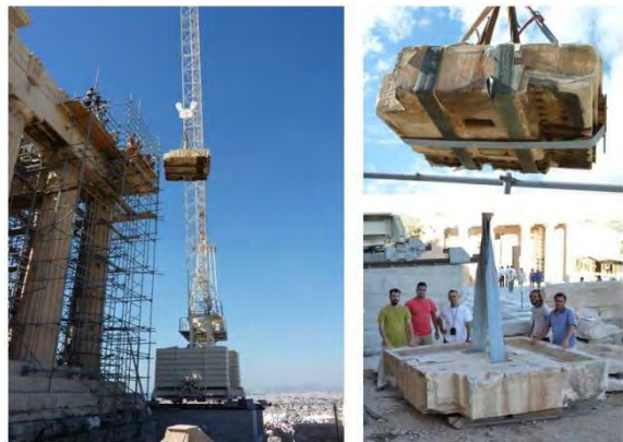
Εικόνα 4 Αποξήλωση ΒΔ γείσου.
