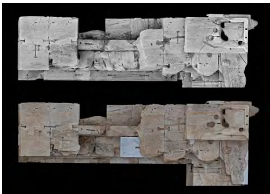
Εικόνα 7 Ορθοφωτομωσαϊκά της κάτωτης της ΒΔ γωνίας του Παρθενώνα, πριν και μετά την αποκατάσταση.
