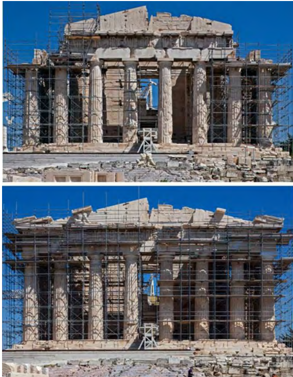
Εικόνα 3 Αποκατάσταση της ΒΔ και ΝΔ γωνίας του θριγκού του Παρθενώνα.
