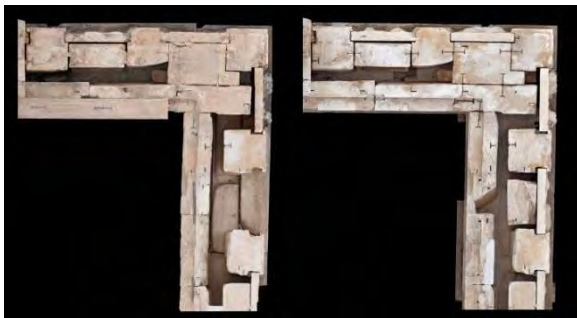
Εικόνα 6 Ορθοφωτομωσαϊκά της κάτωτης της στρώσης των τριγλύφων – διαζωμάτων της ΒΔ γωνίας του Παρθενώνα, πριν και μετά την αποκατάσταση.
