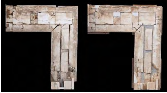
Εικόνα 5 Ορθοφωτομωσαϊκά της κάτωτης της στρώσης των επιστυλίων της ΒΔ γωνίας του Παρθενώνα, πριν και μετά την αποκατάσταση.
